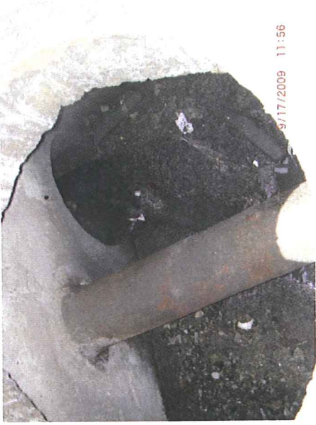
Sector Puerto Nuevo Sur- Int. Calle Andalucía y Calle Alesia
