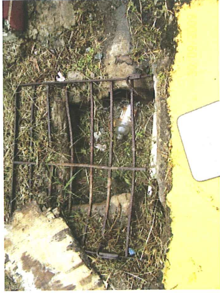
Sector Jurutungo_ Calle Patillas frente a Residencia # 81
